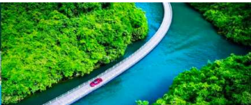
นั่งรถผ่านชมถนนลอยน้ำด่านสิงหนัง
